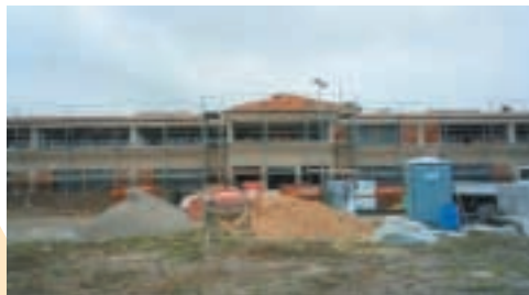
工事中の新工場
