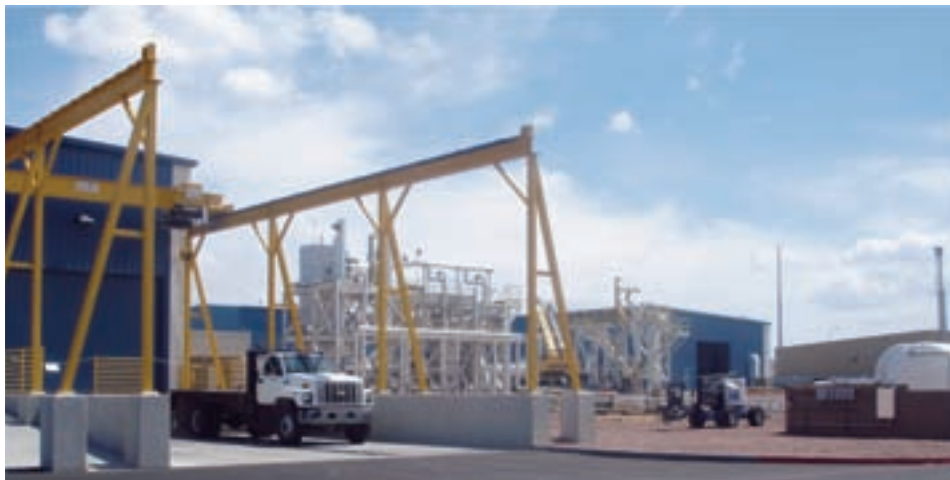
拡張工事が完了した Nikkiso Cryo, Inc.
