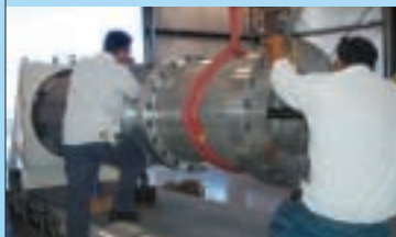
ポンプ組み立て
