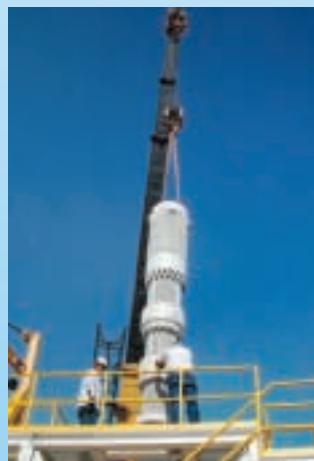
試験ポンプ引き抜き
