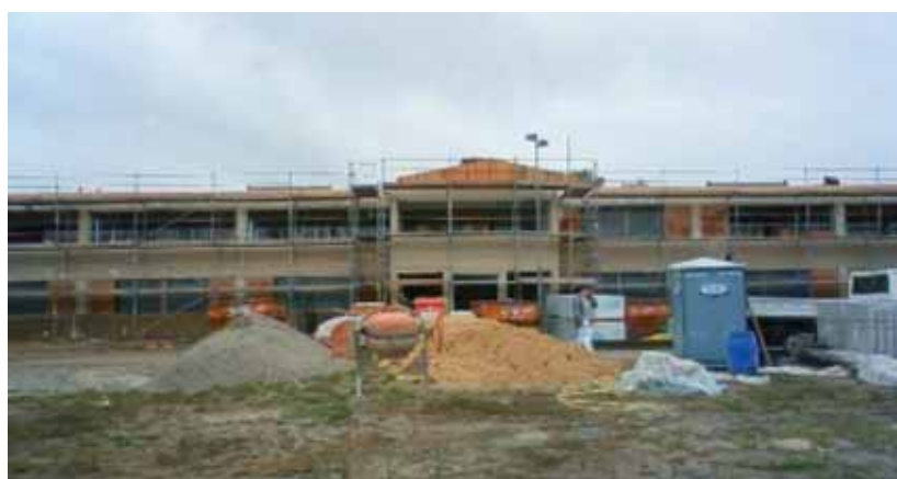
工事中の新工場
