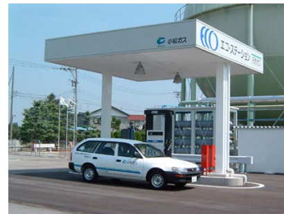
天然ガス充填スタンド
